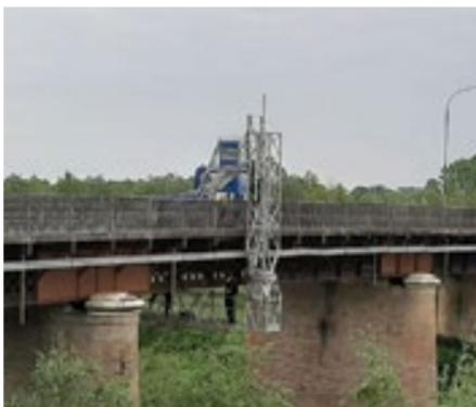
Si sono svolte nei giorni scorsi, con l'utilizzo di un camion leggero con bay-bridge, una serie di indagini ed ispezioni dell'intradosso del **ponte Vecchio**. Analisi che hanno richiesto l'esecuzione di alcune prove strutturali al fine di determinare con maggiore certezza e informazioni lo stato di degrado delle strutture.
