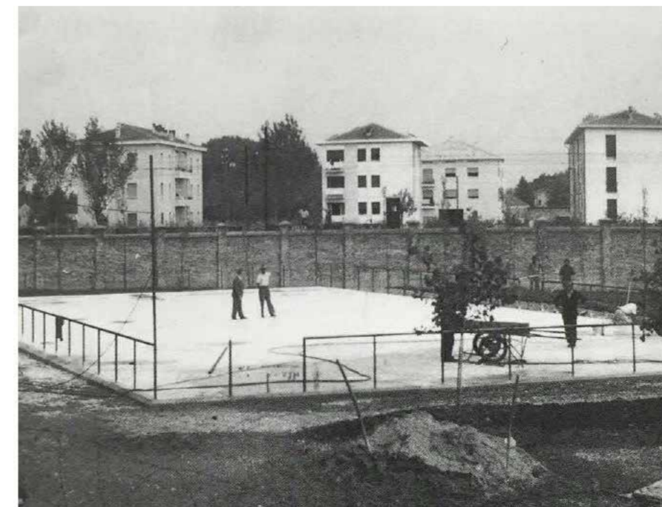
LA PISTA DI PATTINAGGIO IN CORSO DI COMPLETAMENTO, 1960
